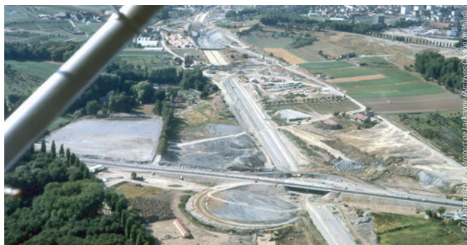
La jonction de Malley en construction, environ 1962.
