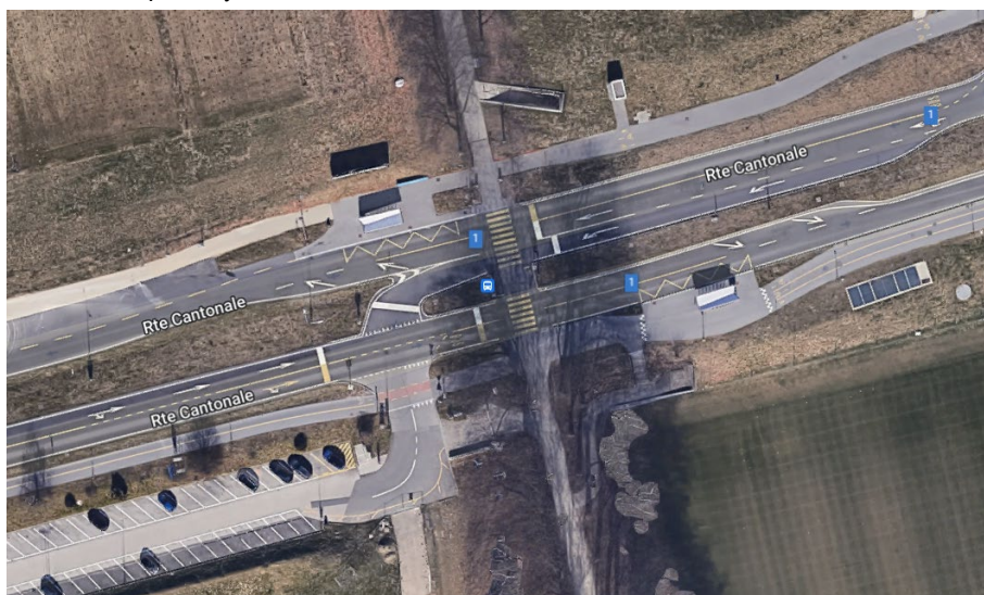
Figure 47 – Poste 549 : Route Cantonale – Allée de Dorigny
