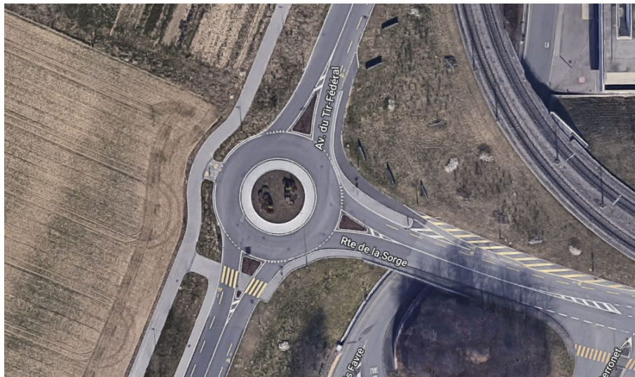
Figure 46 – Poste 571 : Tir-Fédéral - Sorge
